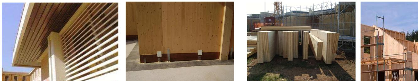
Quindi sistema portante principale in legno ed acciaio, sia per quanto riguarda le strutture verticali che orizzontali. Ma anche solai, tamponamenti e partizioni interne in legno con tracce impiantistiche realizzate in fase di prefabbricazione.
